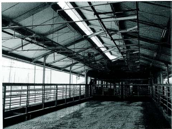
パラーの待機場にはスプリンクラーを設置し、搾乳間の暑熱対策にも利用する
